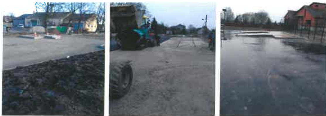
19 pav. Pandelio ir Joniškėlio didelių gabaritų aikštelių statybos darbai
