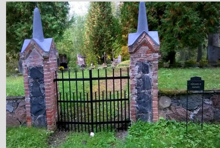
Atnaujinti kapinių vartai Kuginių kapinėse
