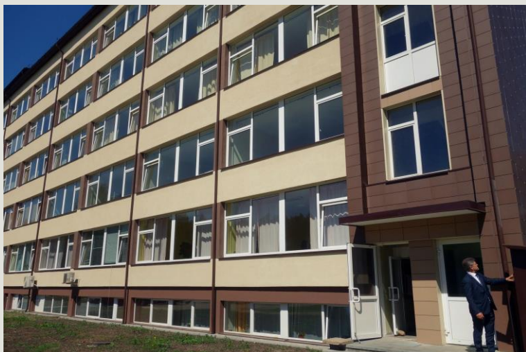
Modernizuojami ligoninės pastatai
